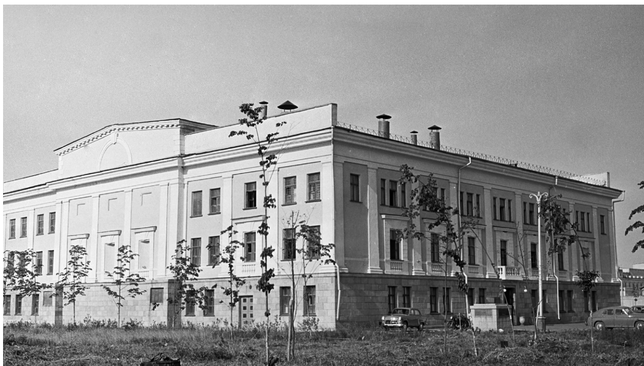
© РИА Новости, Марк Редькин Общий вид главного здания первой атомной электростанции Академии наук СССР в Обнинске.
