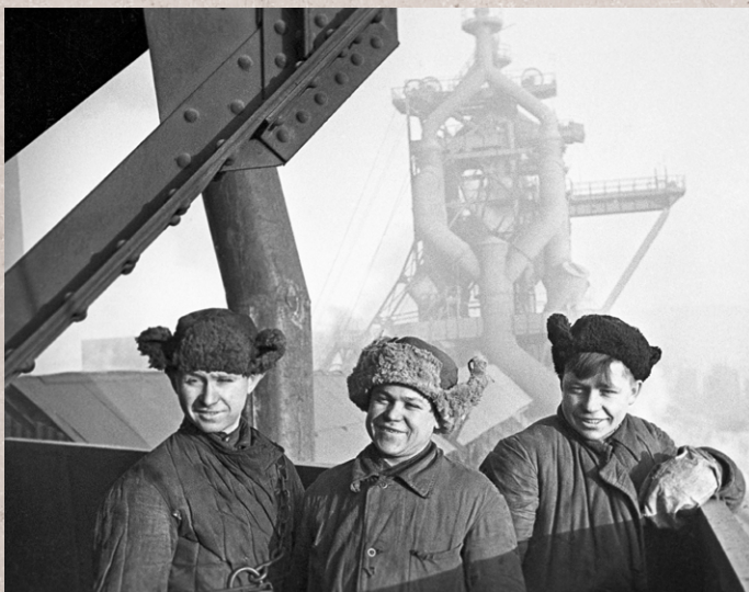
© РИА Новости, Иван Шагин Великая Отечественная война 1941-1945 гг. Комсомольцы на стройке шестой домны Магнитогорского металлургического комбината.
